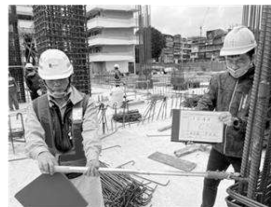
現場柱鋼筋續接器扭力試驗
