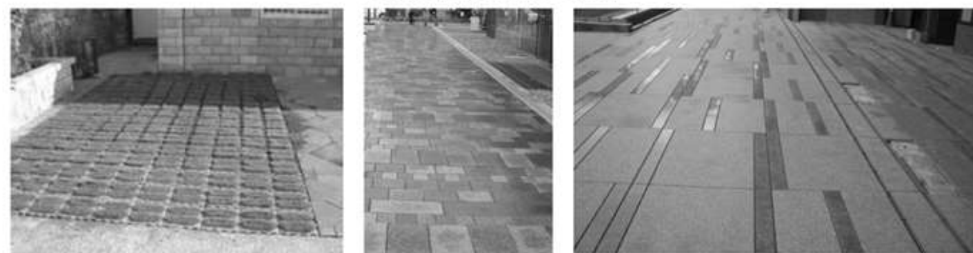
透水性鋪面「連鎖磚型」
