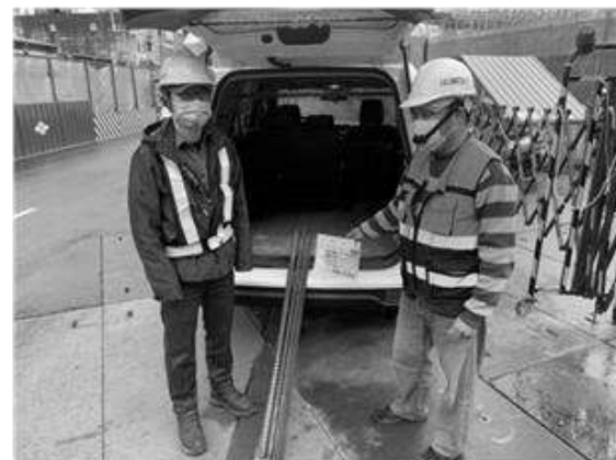
現場鋼筋試體取樣
