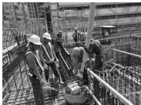
混凝土管尾取樣
