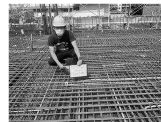
樓板鋼筋綁紮查驗
