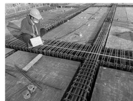
梁鋼筋綁紮查驗
