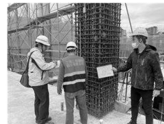
柱鋼筋綁紮查驗
